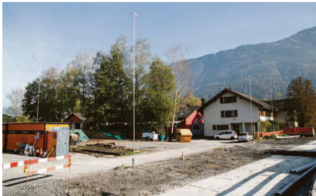
Voller Vorfriede zeigt Rebecca Marxer, Bereichsleiterin Wohnen im HPZ, wie das neue «Birkahus» aussehen soll. Voraussichtlich im Dezember ist der Spatenstich, nach rund einem Jahr Bauzeit dürfen die 13 Bewohner dann in ihr neues Zuhause einziehen.
